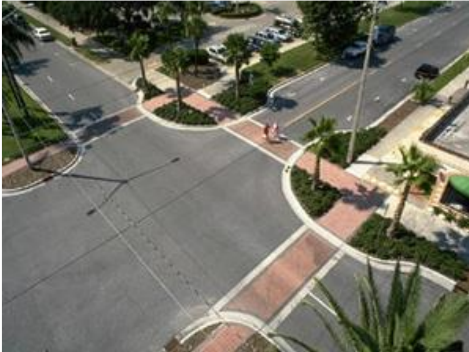
Figura 98 – Estreitamento de pista
